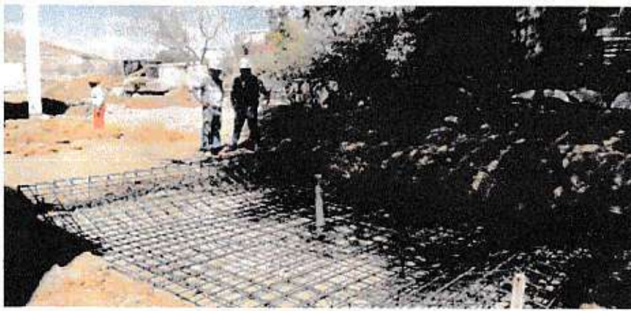
VERIFICACION DE ACERO, ENCOFRADO E INSTALACION DE DRENAJE PLUVIAL EN RODALUVIO
