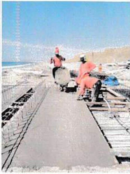
VACEADO DE LOSA PREFABRICADA
