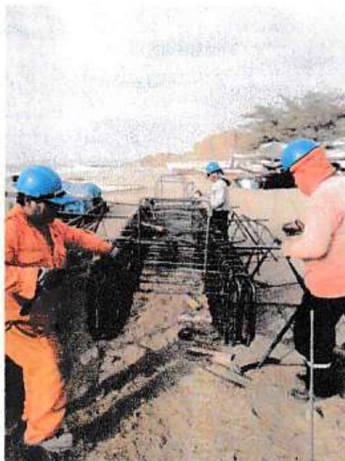
HABILITADO DE ACERO PARA LOSA PREFABRICADA Y VIGAS PREFABRICADAS
