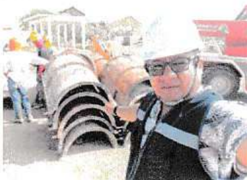
ENFUNDADO METALICO PARA PILOTES
