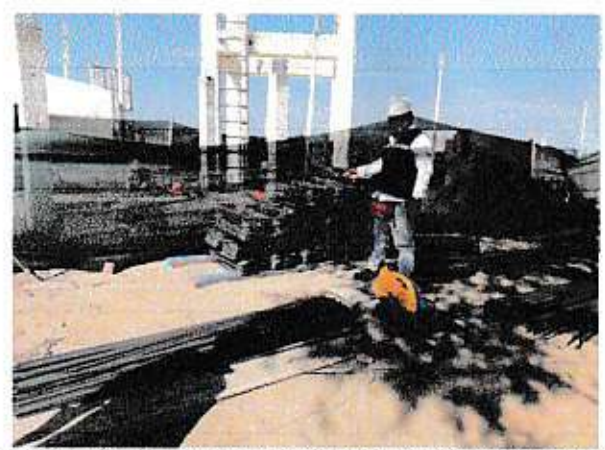
VERIFICACION DE HABILITADO DE ACERO PARA VIGA PREFABRICADA
