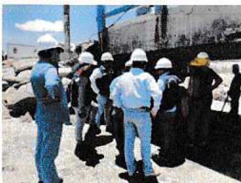
VERIFICACION DEL PILOTE 1ER EJE
