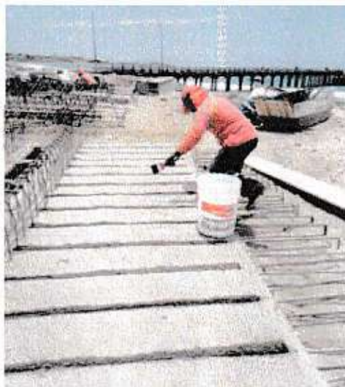
CURADO DE ELEMENTOS PREFABRICADOS
