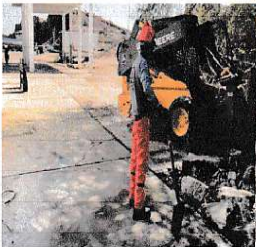
DEMOLICION DE LOSA
