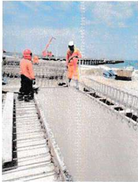
VIBRACION DE LOSA PREFABRICADA
