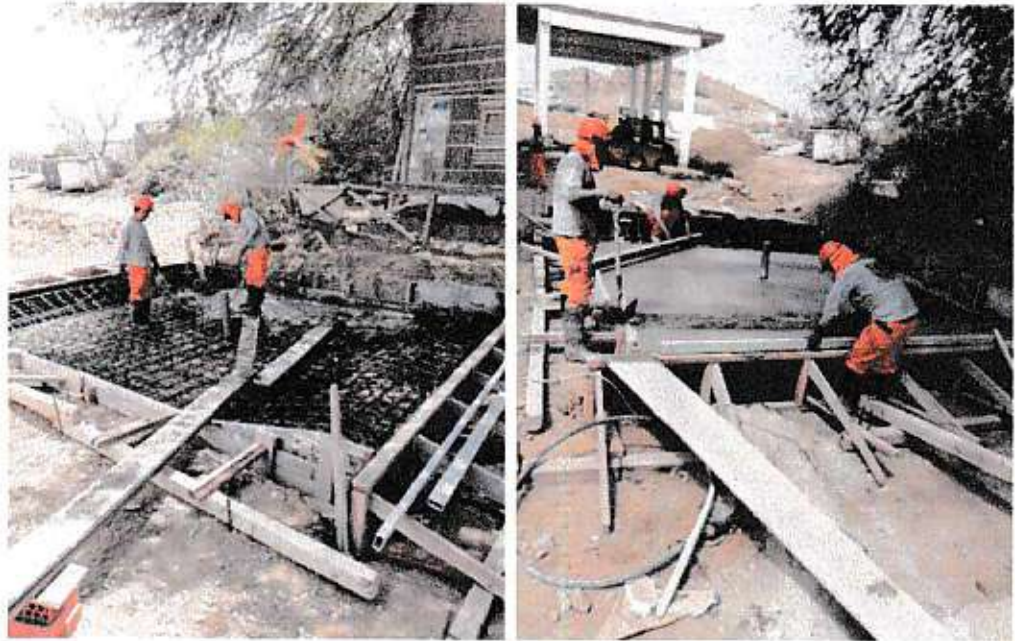
VACEADO DE CONCRETO F'c=280KG/CM2 EN RODALUVIO
