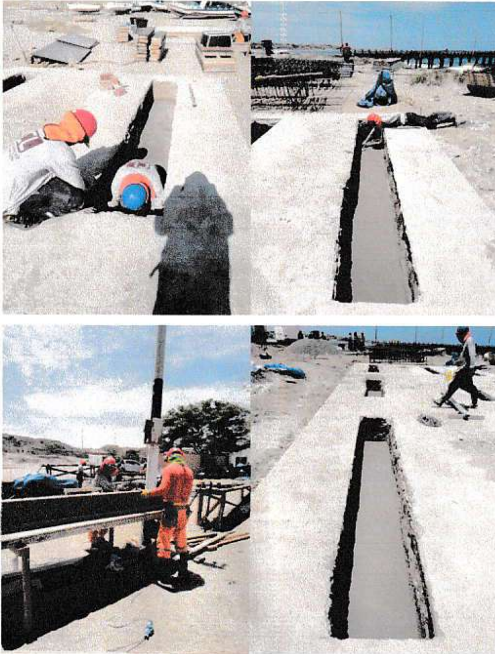
HABILITADO DEL ENCOFRADO PARA LOSA PREFABRICADA
