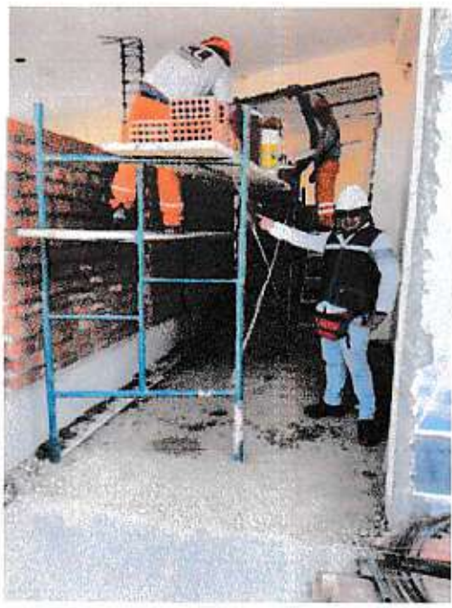
ASENTADO DE LADRILLO EN REMODELACION TAREAS PREVIAS
