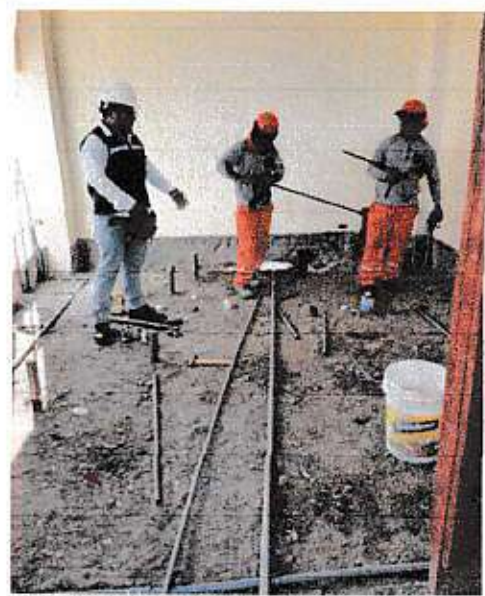
VERIFICACION DE INSTALACIONES SANITARIAS
