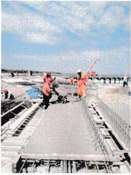
VACEADO DE LOSA PREFABRICADA
