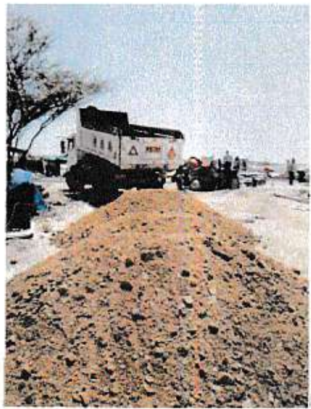
AFIRMADO PARA PATIO DE MANIOBRAS
