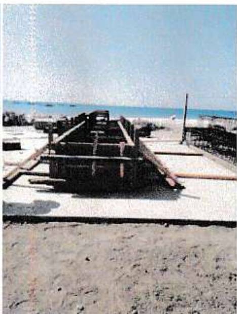
COLOCACION DE ARMADURA EN ENCOFRADO DE VIGA - LOSA PREFABRICADA
