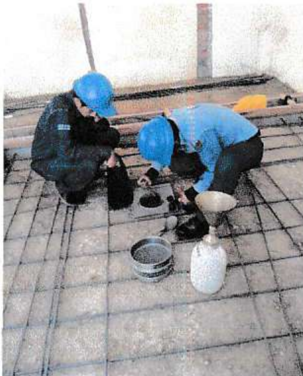
ENSAYO DE COMPACTACION AL AFIRMADO EN AMBIENTE LAVADO DE CAJAS
