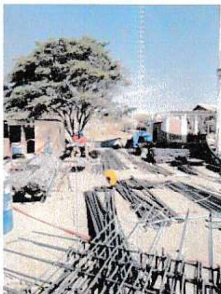
HABILITADO DE ARMADO DE ACERO PARA LOSA DE PATIO DE MANIOBRAS
