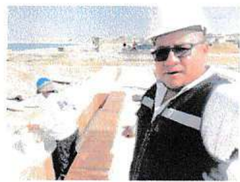
COLOCACION DE DESAMOLDANTE PARA ENCOFRADO DE LOSA PREFABRICADA
