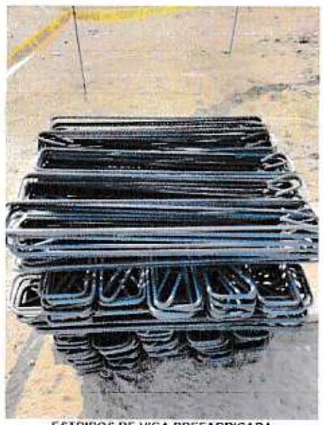
ESTRIBOS DE VIGA PREFABRICADA
