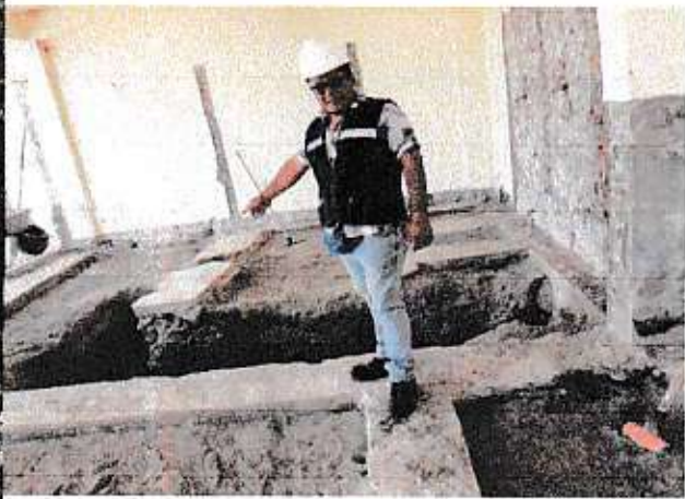
EXCAVACION PARA CIMENTO CORRIDO
