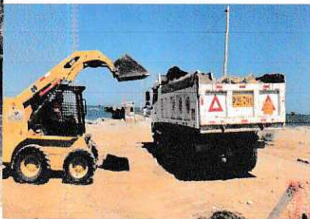
ELIMINACION DE MATERIAL EXCEDENTE
