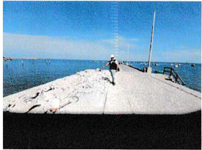
DEMOLICION DE LOSA DE CABEZO
