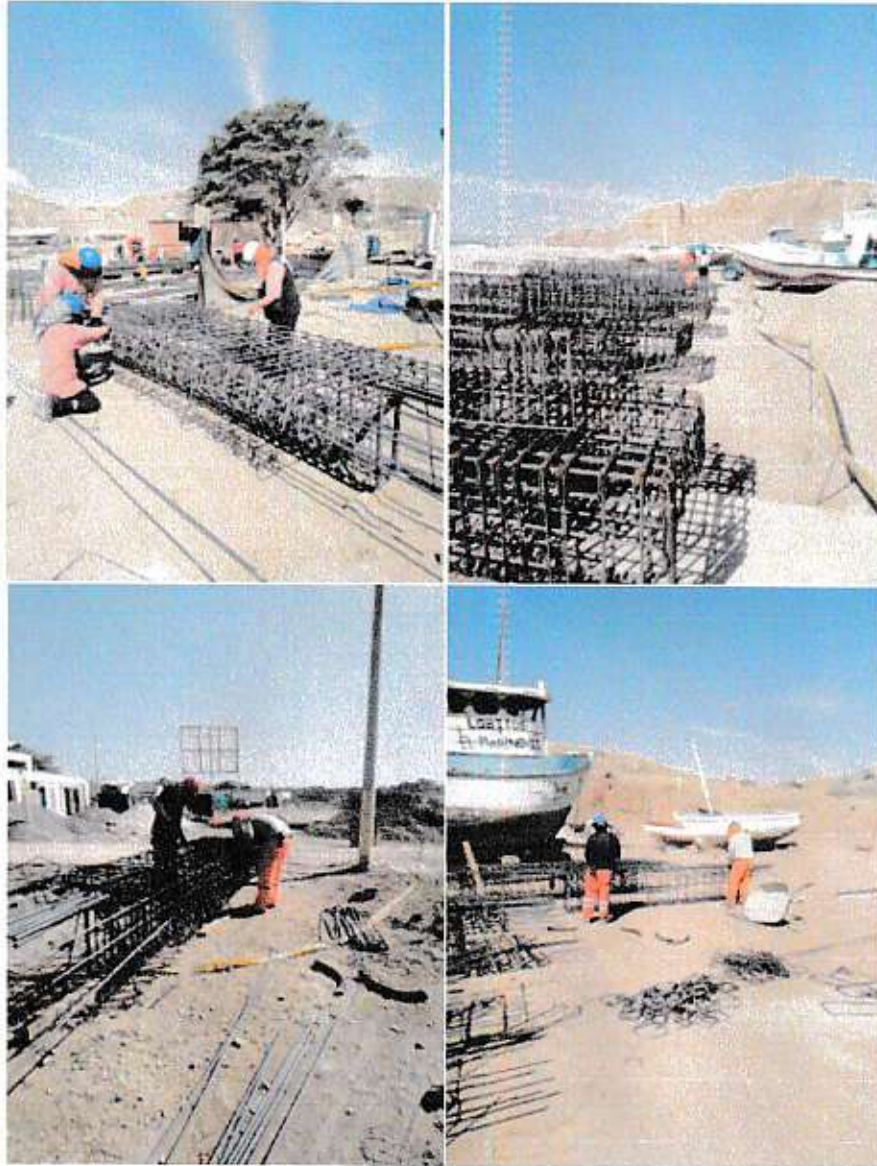
HABILITADO Y ARMADO DE LOSA Y VIGA PREFABRICADA
