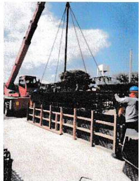
COLOCACION DE ARMADURA EN ENCOFRADO DE VIGA - LOSA PREFABRICADA
