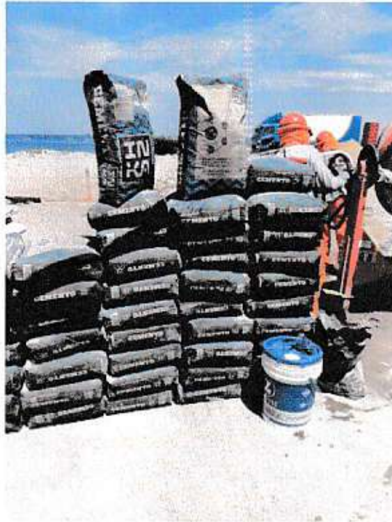
VERIFICACION DEL MATERIAL EN OBRA
