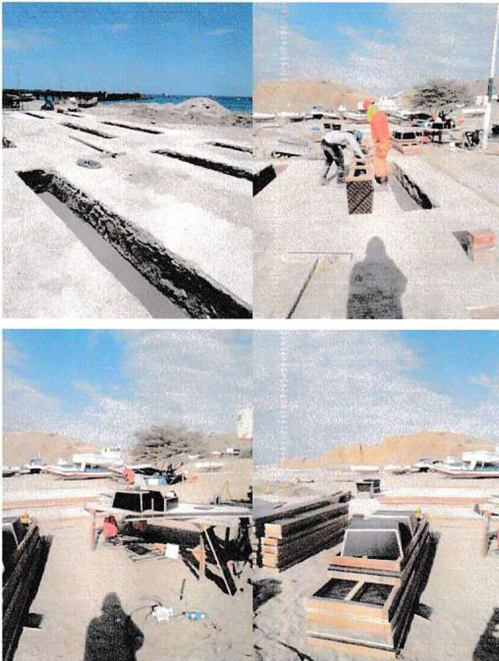
HABILITADO DEL ENCOFRADO PARA LOSA PREFABRICADA
