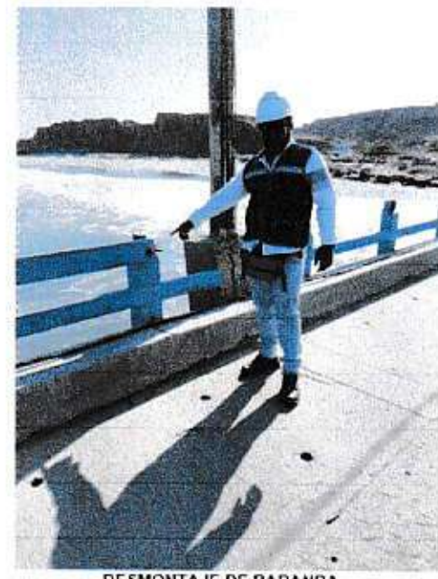
DESMONTAJE DE BARANDA
