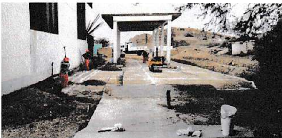
COMPACTACION DE AFIRMADO EN PATIO DE MANIOBRAS
