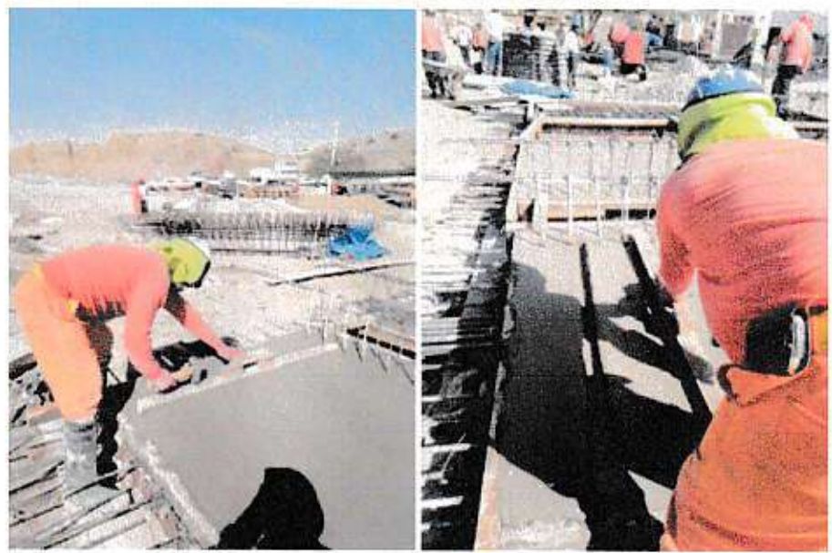
BRUÑADO DE LOSA PREFABRICADA
