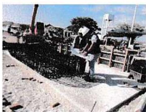
HABILITADO Y ARMADO DE LOSA Y VIGA PREFABRICADA
