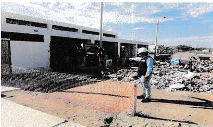
ACARREO DE DESMONTE PRODUCTO DE ELIMINACION
